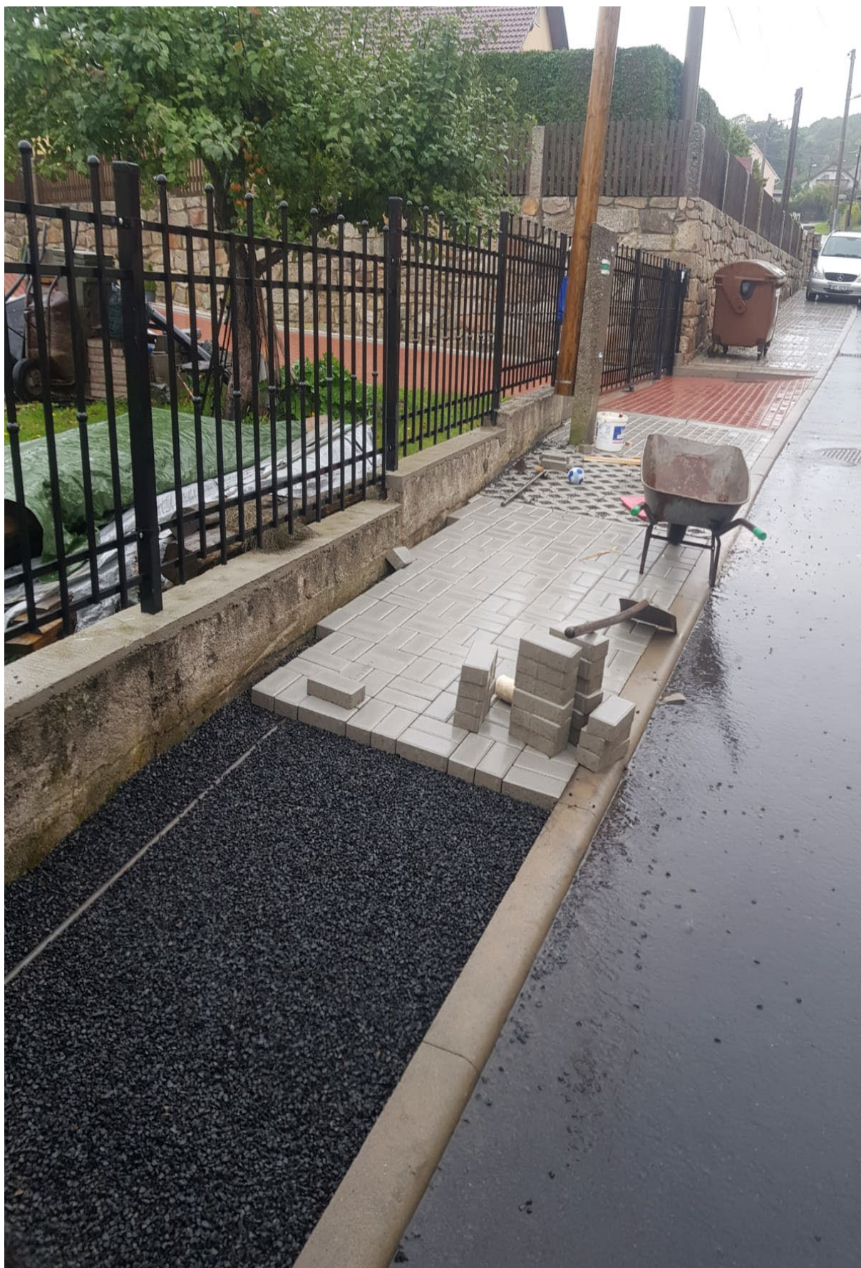
Dokončení chodníku v tzv.Kolmé ulici ve Stružné
